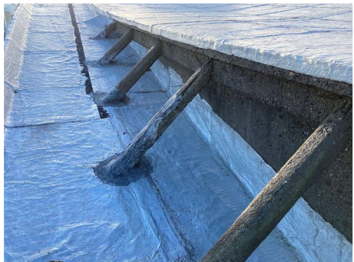
IMAGEN 6 – ANCLAJES DE LA CUBIERTA
