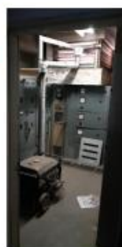
Grupo generador sin mantenimiento y falta de orden y limpieza del recinto.
