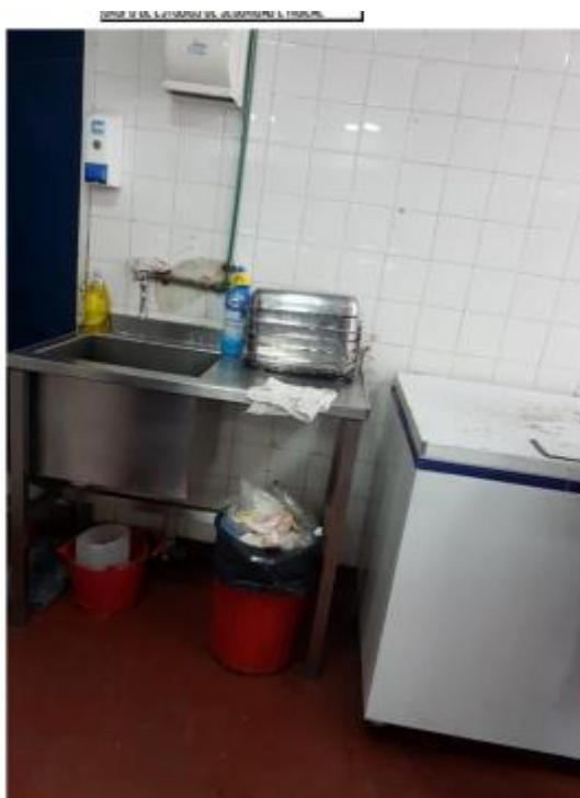
Foto 50 Recipientes de residuos sin tapas – Riesgo higiénico
