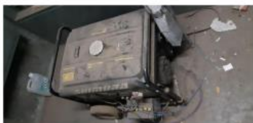
Grupo generador sin mantenimiento y falta de orden y limpieza del recinto.
