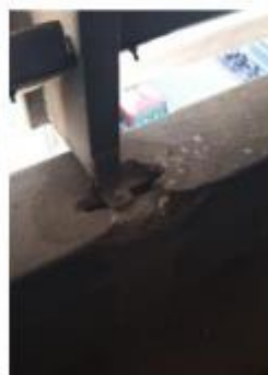
Imagen 18: Presencia de filtraciones en losa, lonas colocadas en cocheras. Falta de anclajes en parasol.
