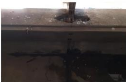
Imagen 18: Presencia de filtraciones en losa, lonas colocadas en cocheras. Falta de anclajes en parasol.
